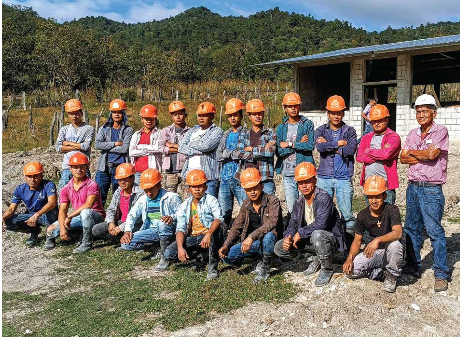
Estudiantes del Taller de Albañilería, frente al edificio que construyen en la aldea de Cololaca, de San Marcos de Caiquín, Lempira.
